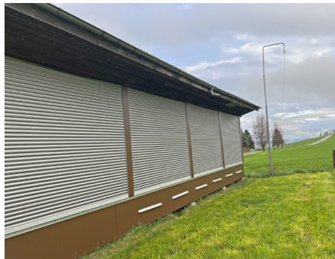
Rolladen und Fassade neu
